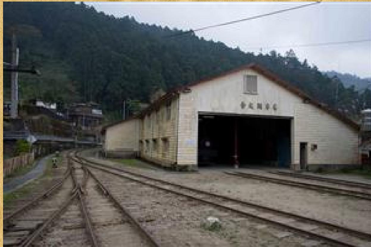
奮起湖是阿里山鐵路的鐵道及車輛維修三站之一，亦為機關車換車處，因此奮起湖除車庫外，還設有機關庫（車庫）、檢車庫及保線單位（今監工區），負責車次換班、養護、補給、驗車及鐵道維修等功能，山地段之行運即以奮起湖站為分界。
